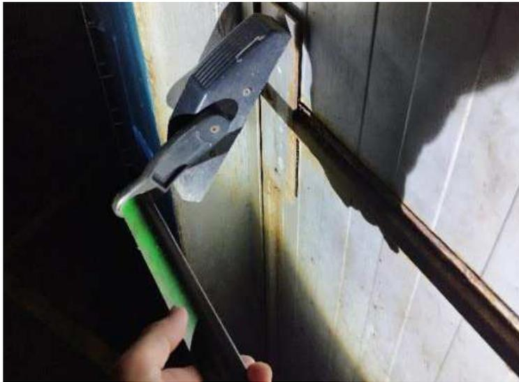
*Fotografías aportadas por Alternativa Sindical a Inspección de Trabajo. Barra antipánico desclavada de la puerta*
