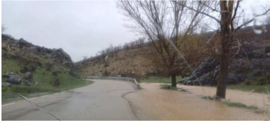
Carretera GU 928 parcialmente cubierta de agua a su paso por Renales, con el arroyo del Barranco de la Vega desbordado a su vera. Fotografía de María Castilla
