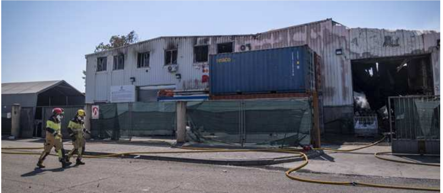
Bomberos junto a la nave incendiada en Azuqueca
