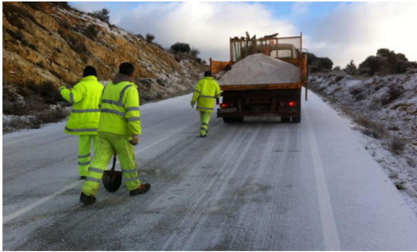
Operarios echan sal en una carretera nevada de la provincia de Guadalajara
