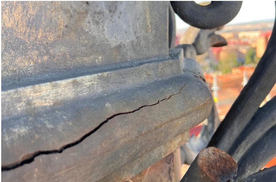
Obras de restauración de la torre del campanario del Ayuntamiento de Guadalajara
