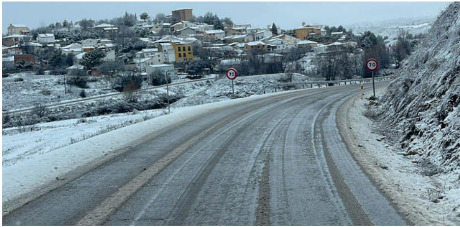
Carretera bajo la nieve. Al fondo, el municipio de Espinosa de Henares.
