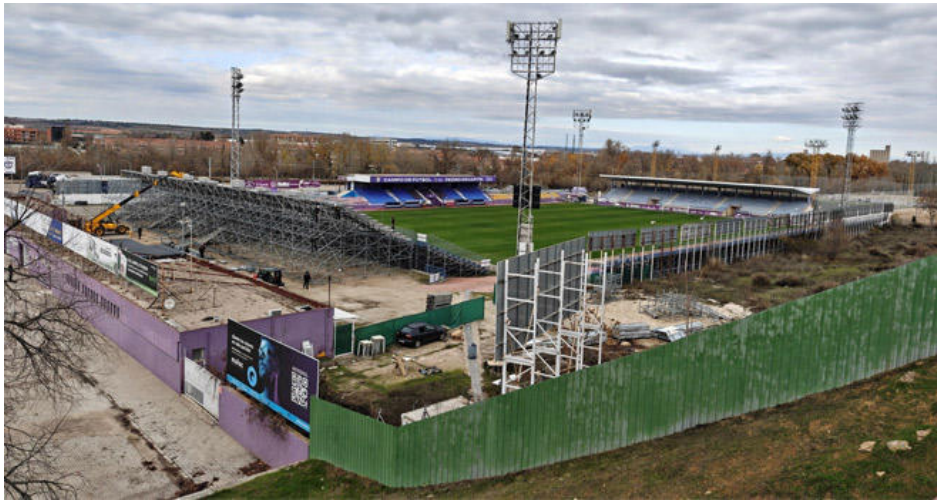
Imagen del montaje de las gradas portátiles antes del partido de Copa del Rey frente al FC Barcelona
