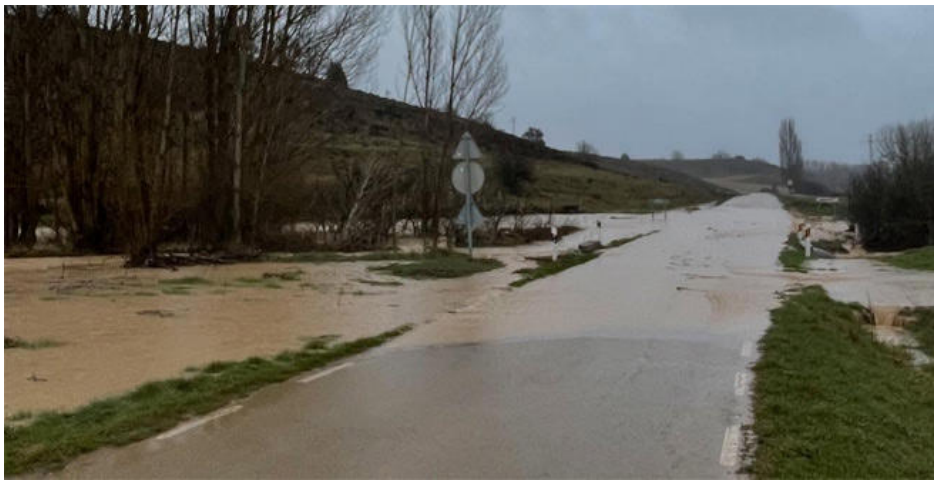
Carretera GU 928 anegada de agua a la altura de Renales. Fuente: Facebook de la comisión de Fiestas de Renales
