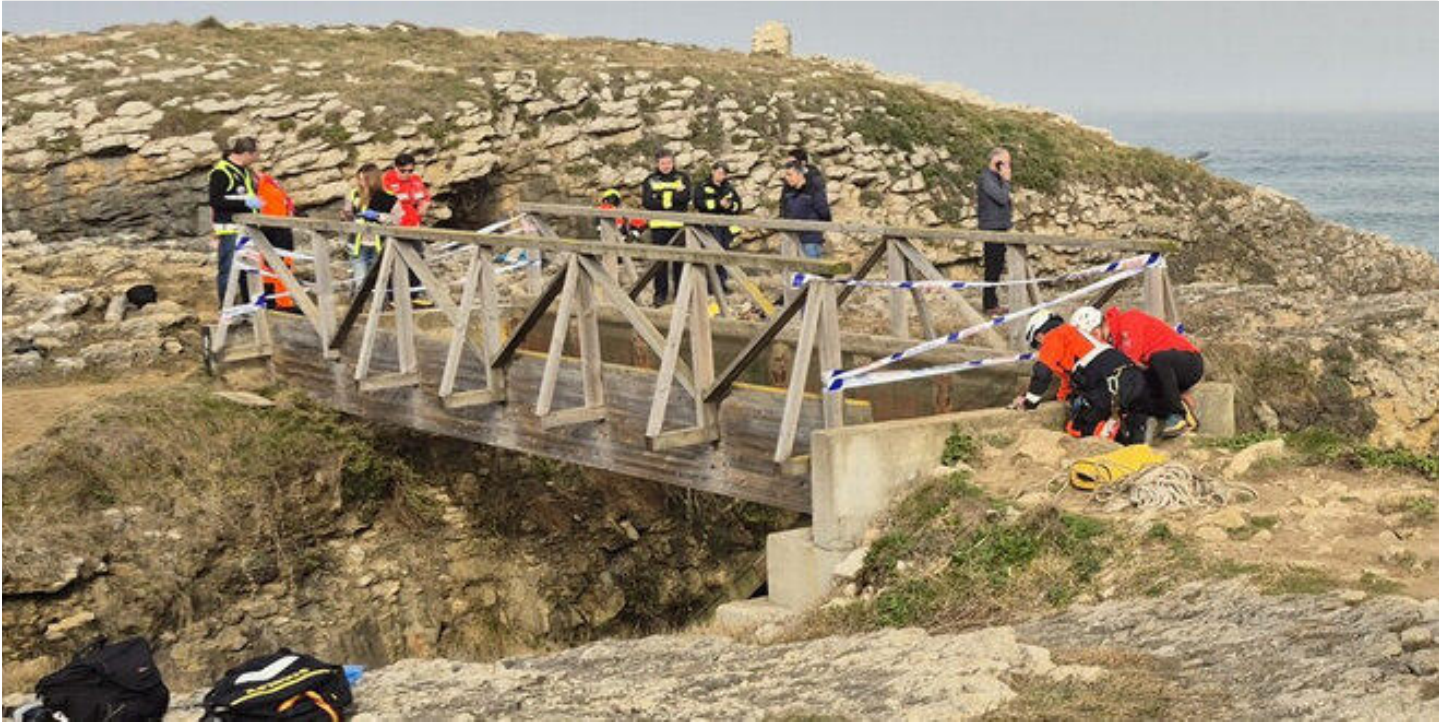
Imagen de la pasarela que se derrumbó al paso de los jóvenes. Fuente: 112 Cantabria
