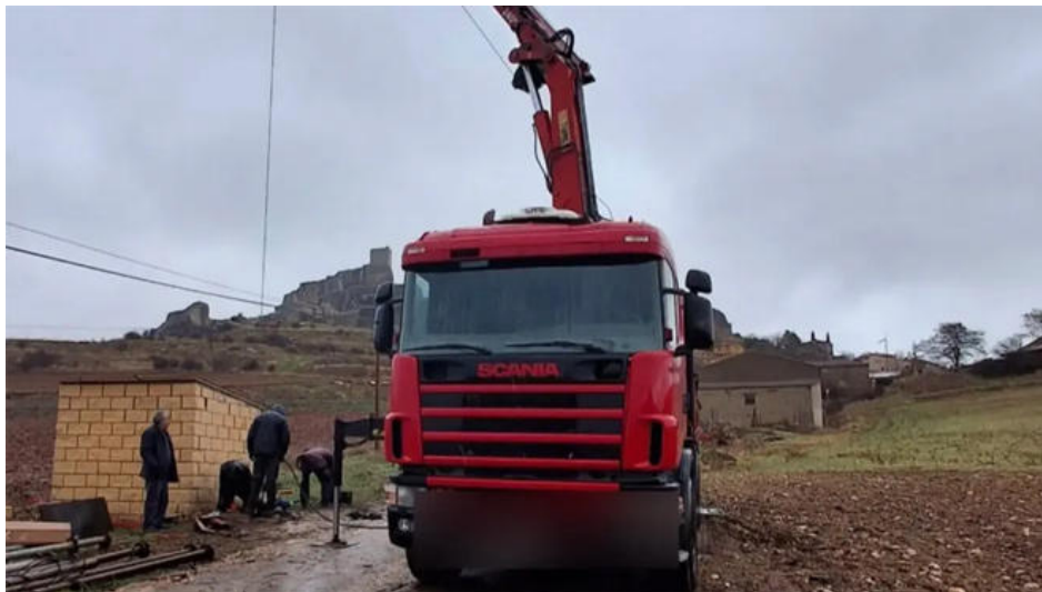
Máquinas trabajando para reparar la avería del pozo de agua potable de Atienza. Fotografía del Ayuntamiento de Atienza
