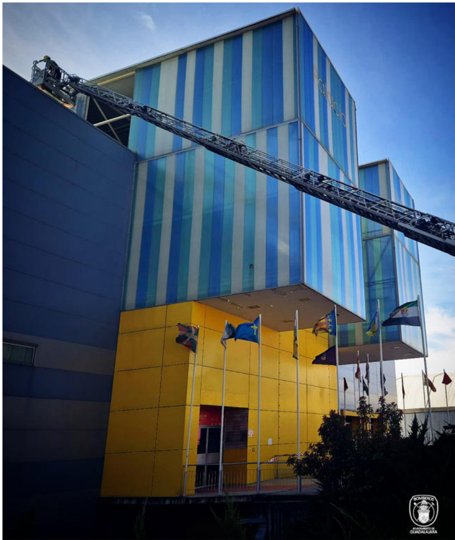
Los bomberos del Ayuntamiento de Guadalajara sobre la cubierta del palacio Multiusos. Fotografía: Bomberos del Ayuntamiento de Guadalajara
