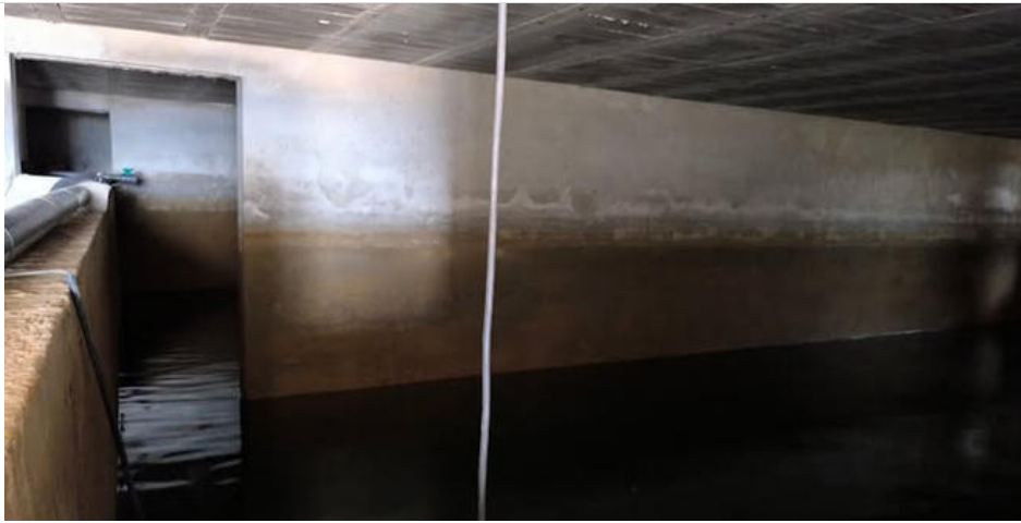
Vista del depósito principal de agua potable de Atienza. Fotografía del Ayuntamiento de Atienza
