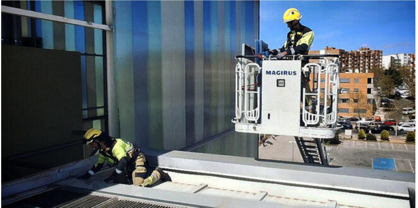
Los bomberos del Ayuntamiento de Guadalajara sobre la cubierta del palacio Multiusos. Fotografía: Bomberos del Ayuntamiento de Guadalajara
