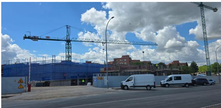
Obras de construcción del nuevo centro de Nipace, en la avenida de la Salinera
