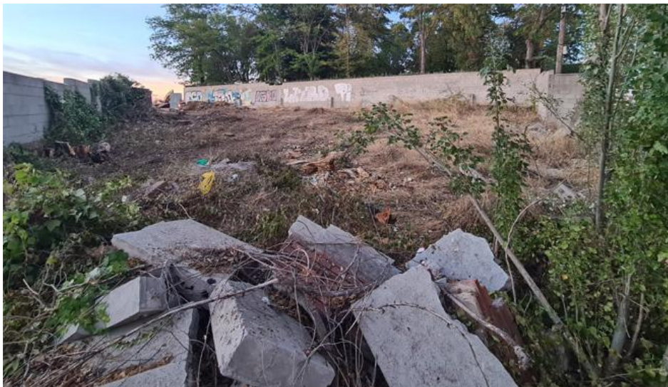
Obras junto al parque de las Cuatro Estaciones. Imagen de Dalma
