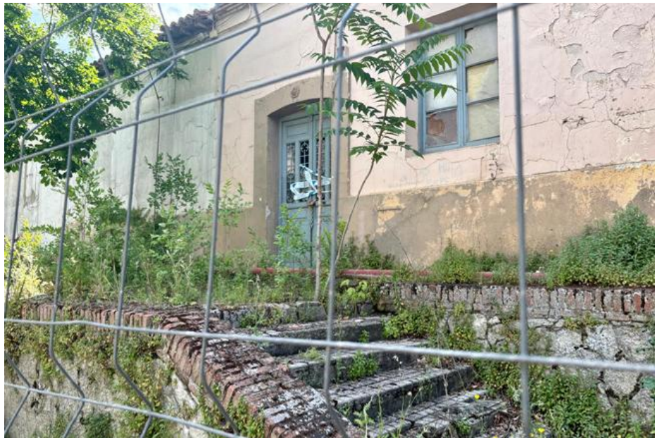
Edificios en estado de abandono en el complejo de El Fuerte de San Francisco en Guadalajara. Fotografía de Cuka Leyre
