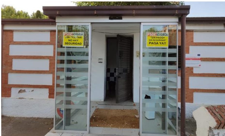
Carteles en la fachada del cuartel de la Policía Local de Azuqueca denunciado el impago de parte del salario a los agentes
