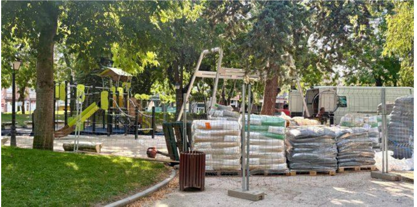
Obras de remodelación de las áreas infantiles del parque de La Concordia en Guadalajara. Fotografía de Cuka Leyre
