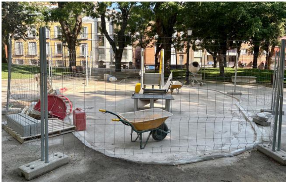
Obras de remodelación de las áreas infantiles del parque de La Concordia en Guadalajara. Fotografía de Cuka Leyre
