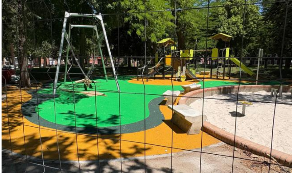
Obras de remodelación de las áreas infantiles del parque de La Concordia en Guadalajara. Fotografía de Cuka Leyre
