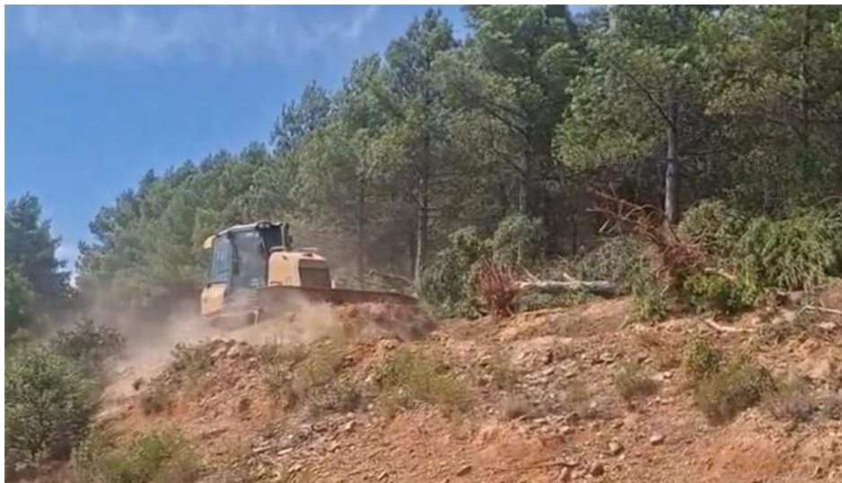
Imagen de una máquina desbrozadora abriendo un cortafuegos en el incendio de La Mierla. Fotografía del Infocam
