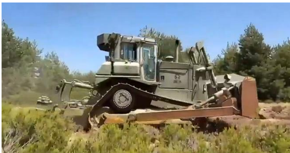
Una excavadora de la UME realiza un cortafuegos en Galve de Sorbe. Imagen de la UME
