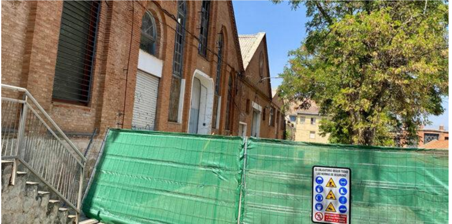
Imagen de las obras de rehabilitación de las naves E y F del Fuerte de San Francisco a fecha 20 de agosto. Fotografía de la JCCM
