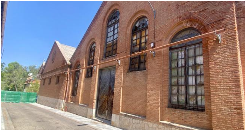
Imagen de las obras de rehabilitación de las naves E y F del Fuerte de san Francisco a fecha 20 de agosto. Fotografía de la JCCM
